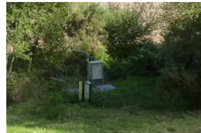
Poste de refoulement dans la zone d'étude
