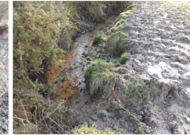
Figure 21 : Ruisseau de Bodéan - berges dégradées par le bétail
