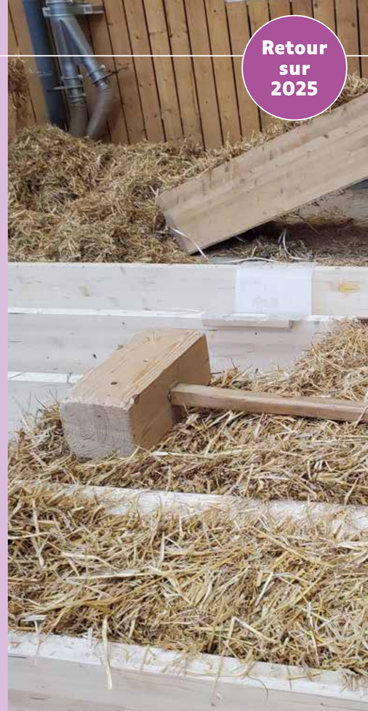
Le Campus datascience et cybersécurité est isolé en paille.
