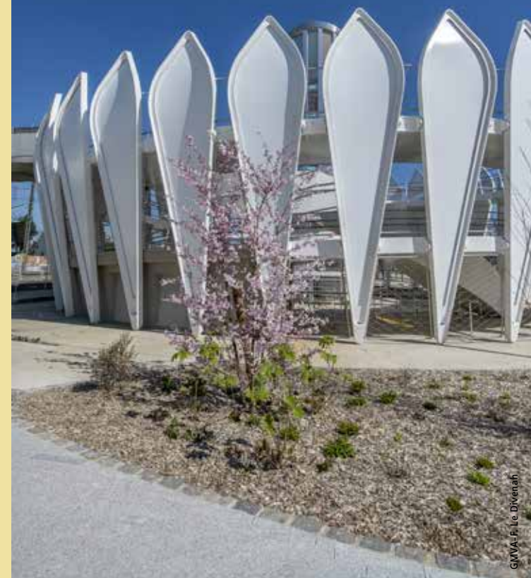
Aménagement du Pôle d'échanges multimodal
