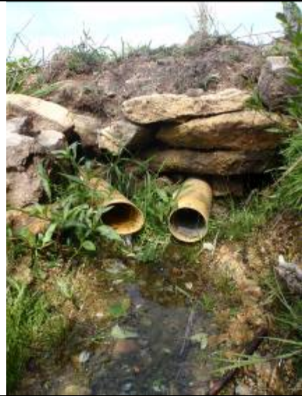
Prairies humides dégradées par remblai et drainage au niveau de Kerléguen et de Guenfroul
