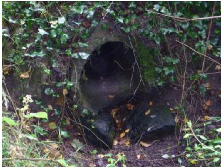
Busage d'un cours d'eau au niveau d'une culture « humide » à la Lande de Portal
