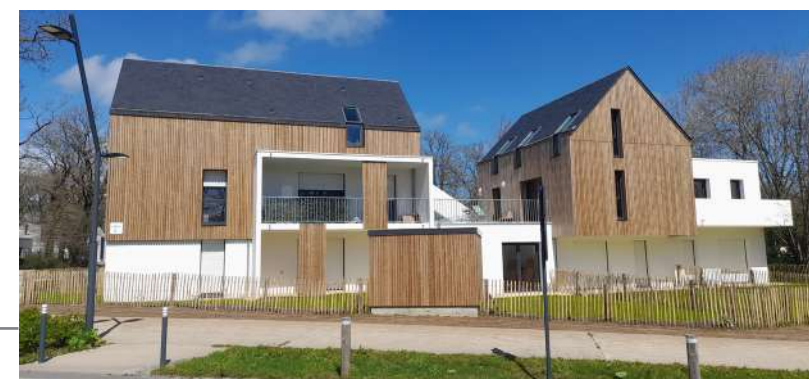
DGA « Les Garennes »
